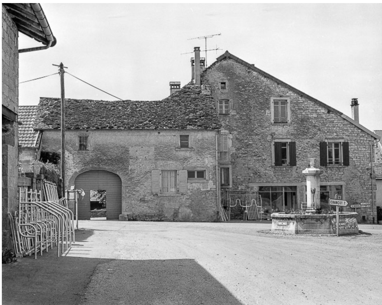
Ferme située place de l'Eglise.
