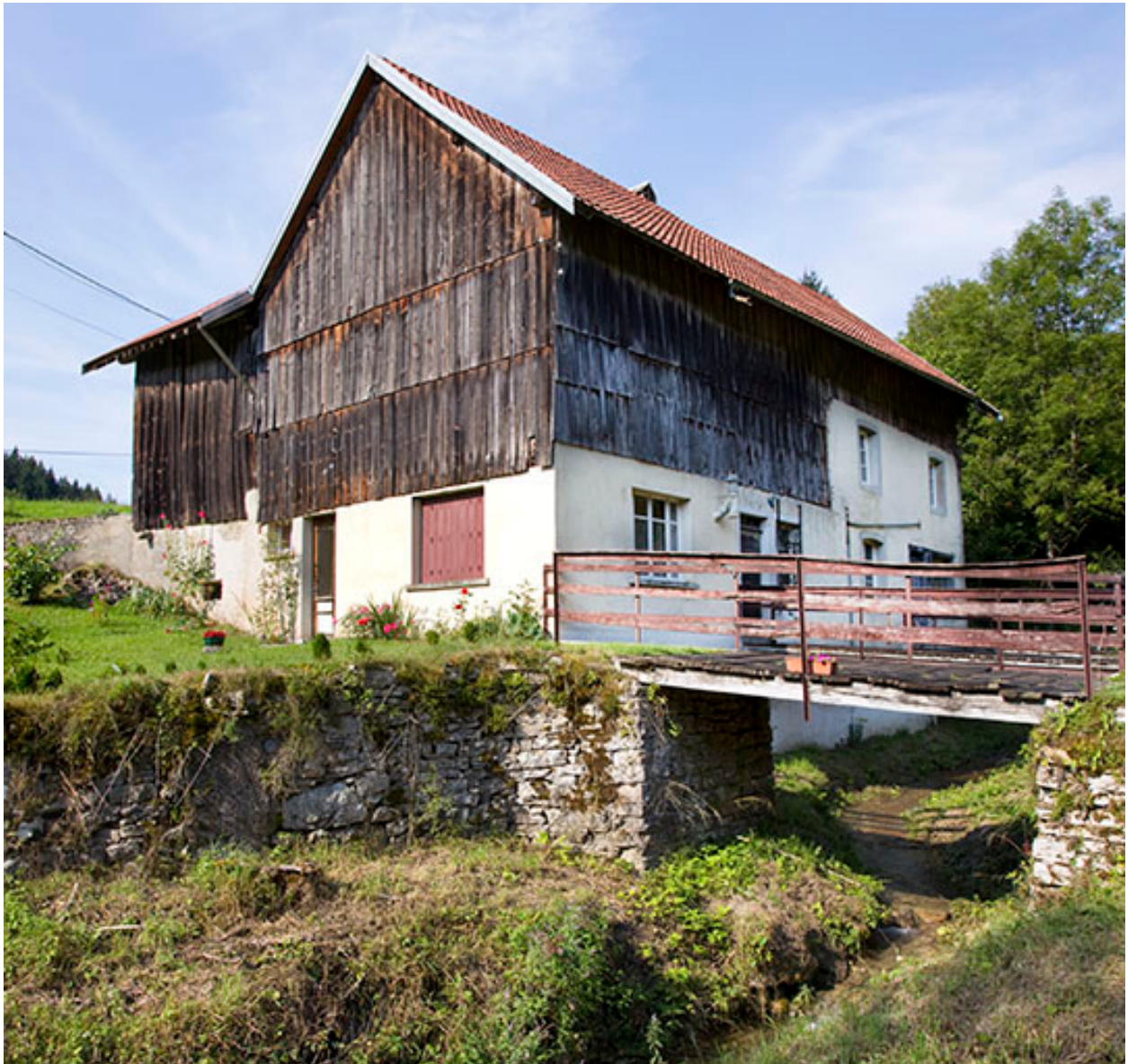
Scierie : façades postérieure et latérale droite.
