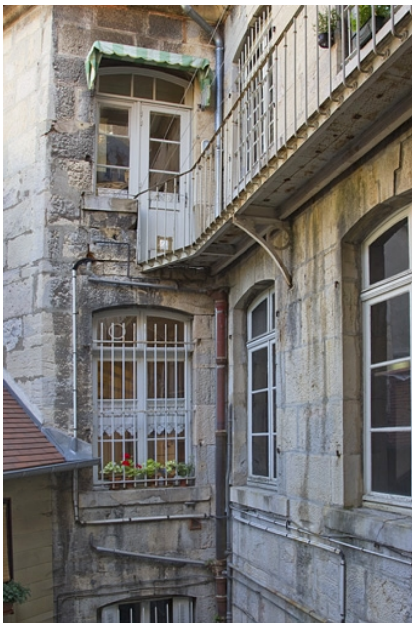
Logis : détail de la façade postérieure.
