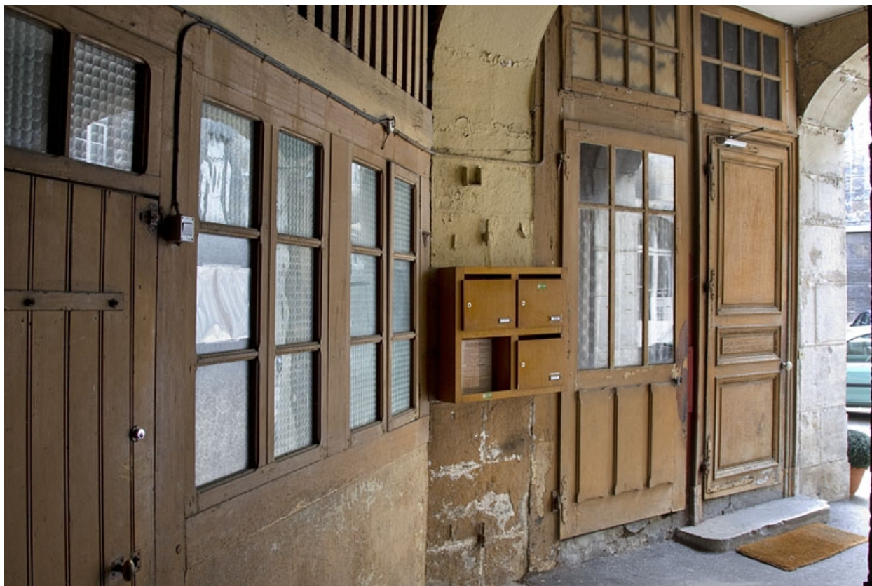
Ecurie : vue de la façade extérieure.
