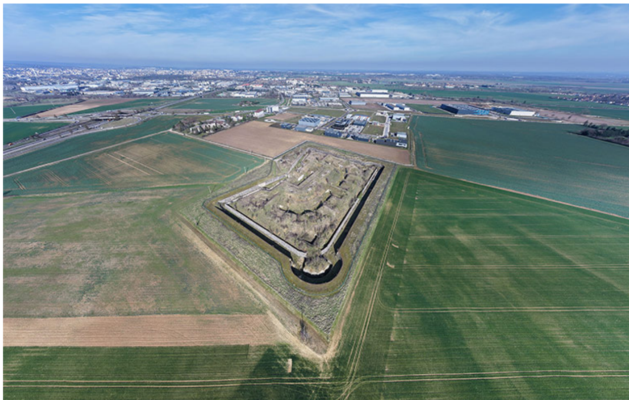
Vue sud-est. (vue aérienne).
