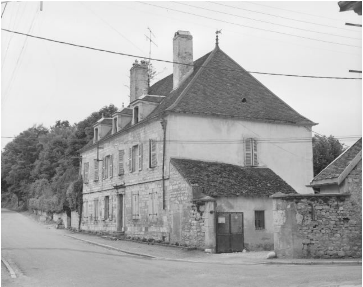
Façades antérieure et latérale droite.
