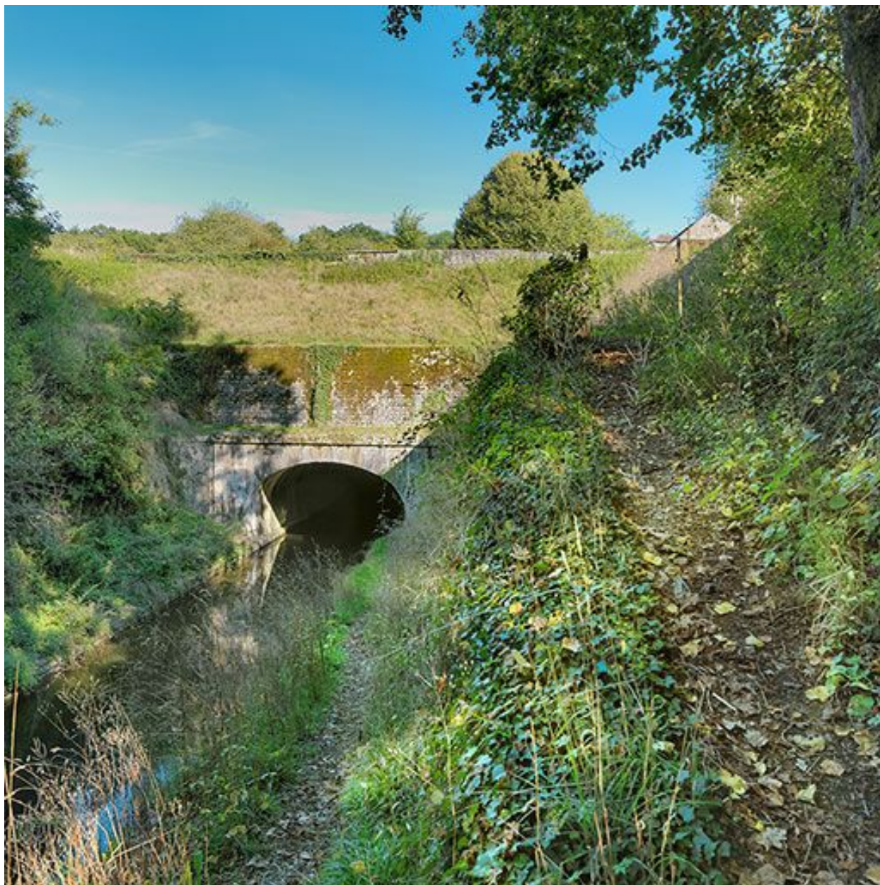
Entrée du tunnel de La Collancelle.
