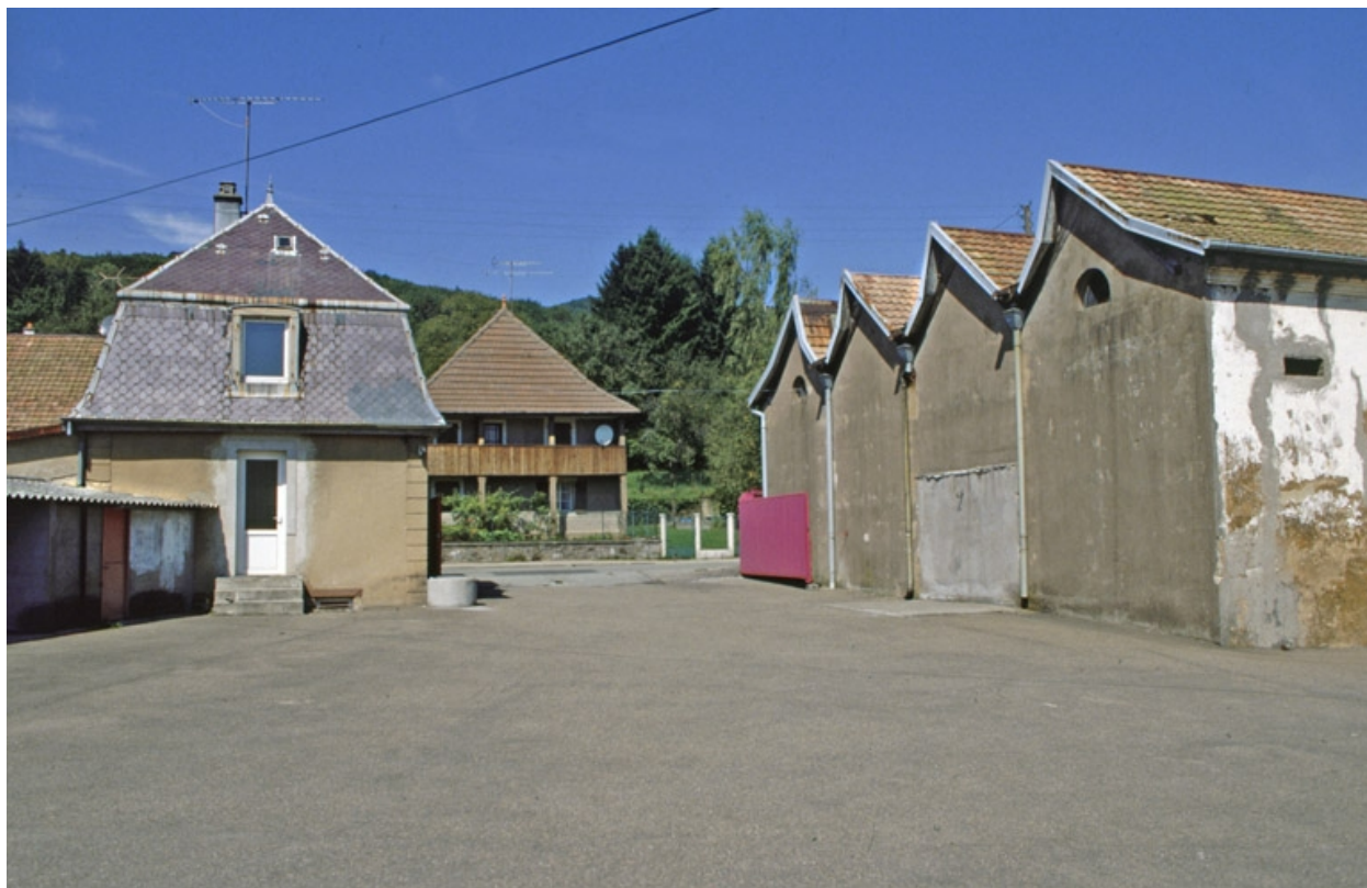
Conciergerie et murs-pignons d'un atelier de fabrication.
