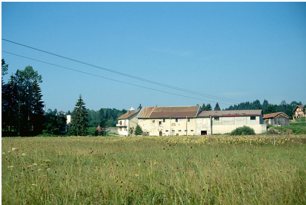
Ateliers de fabrication vus de l'est.
