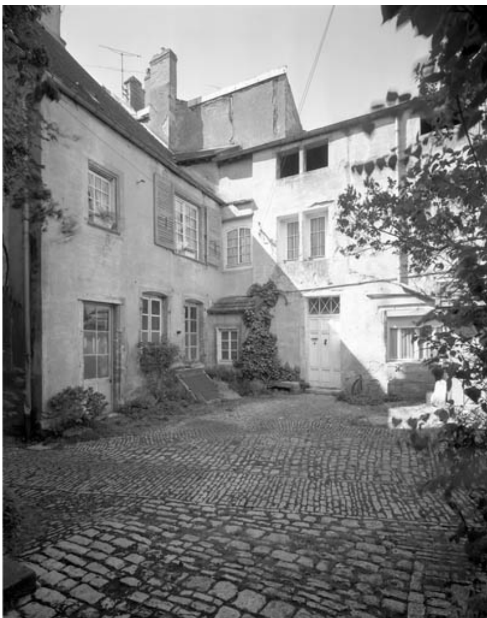
Façades sur cour : vue d'ensemble.
