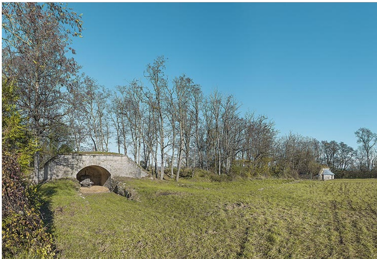
Batterie annexe (droite).
