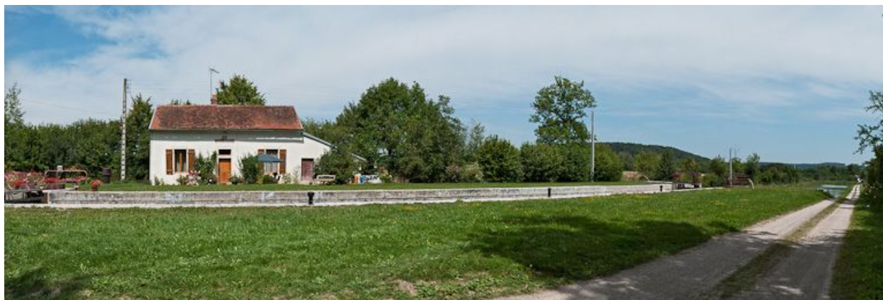
Vue d'ensemble du site d'écluse.
