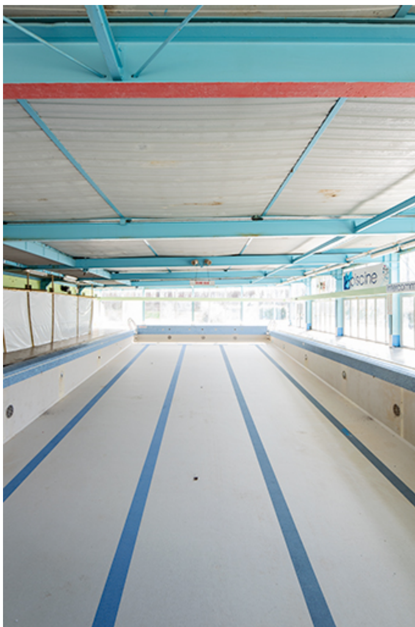
L'ensemble du bassin de la piscine, depuis le nord.
