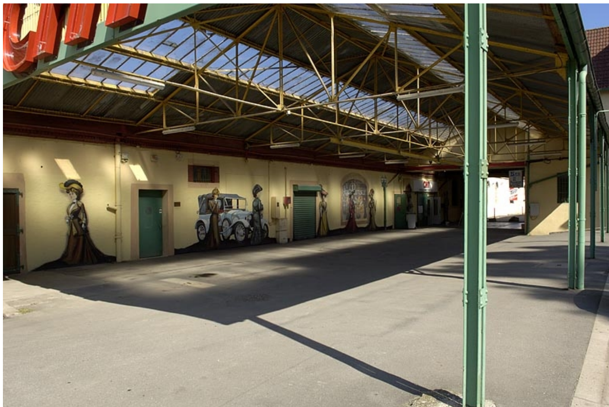
Entrepôt industriel de la salle de tissage.
