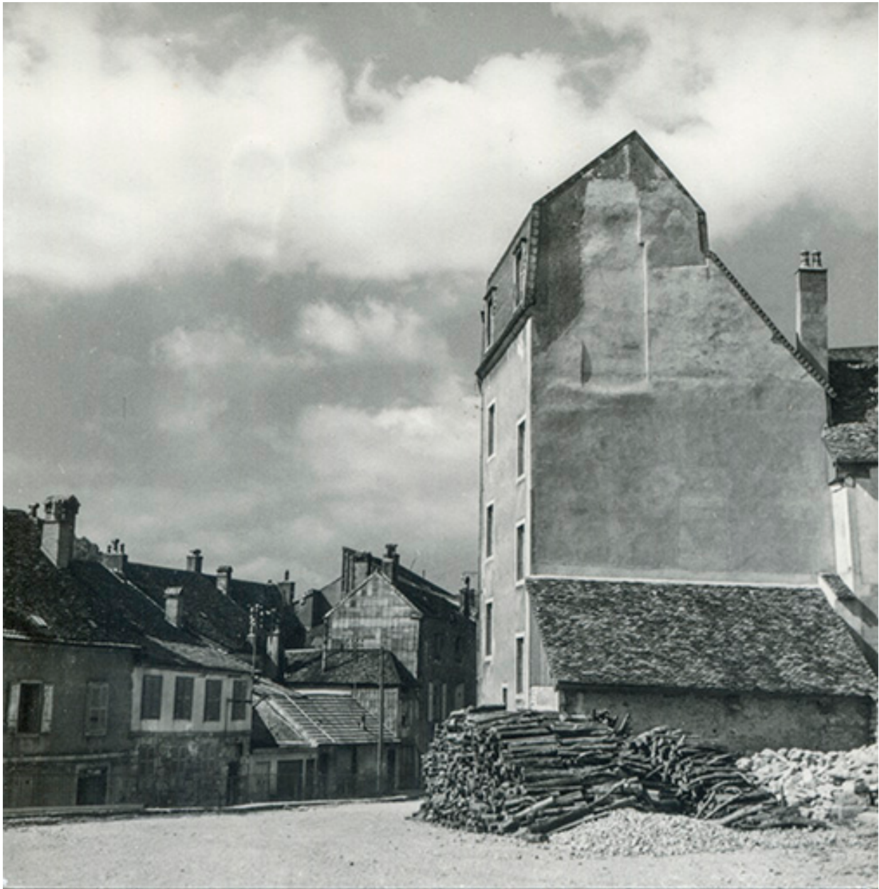
Elévation sud du bâtiment, s.d. [vers 1970].
