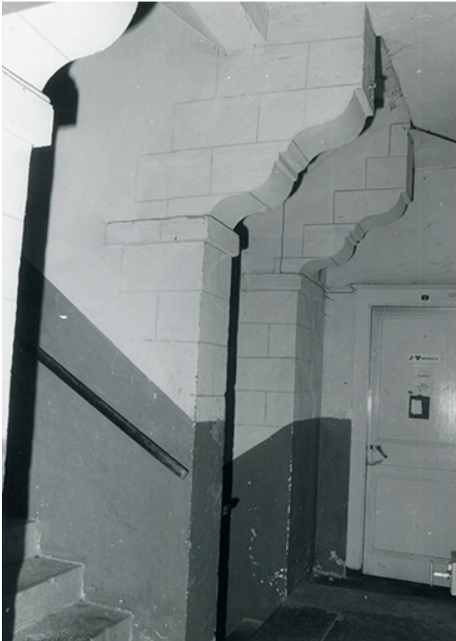
Consoles de l'escalier du couvent, 1985.
