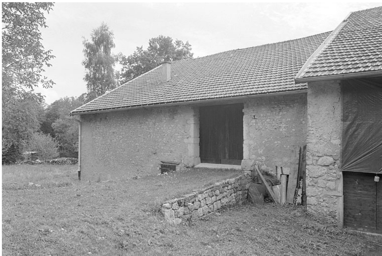
Façade postérieure, grange haute.
