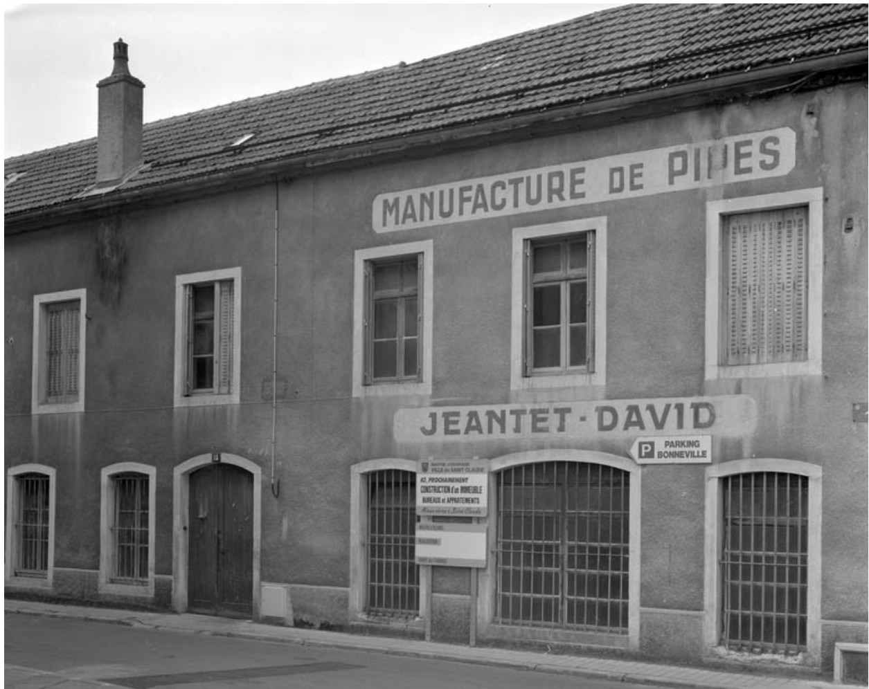
Détail de la façade antérieure.
