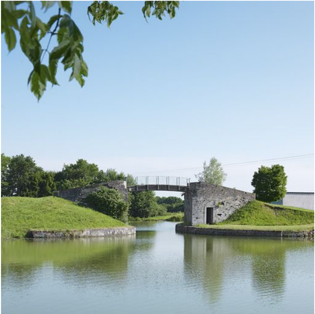
Vue de la passerelle haute, de face.
