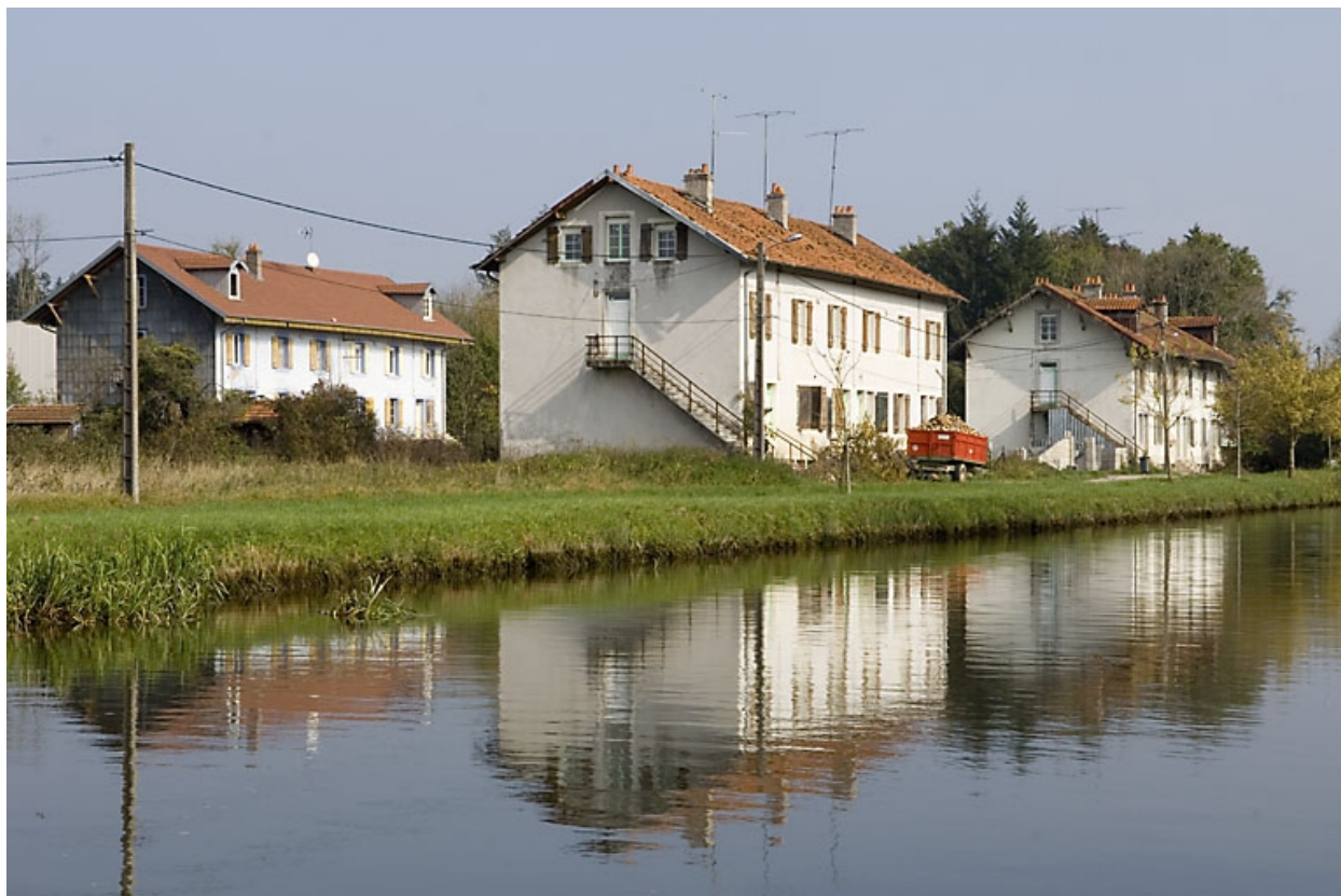
Maisons de la cité ouvrière, depuis le canal.
