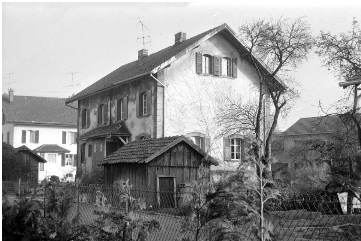
Façades antérieure et latérale droite.
