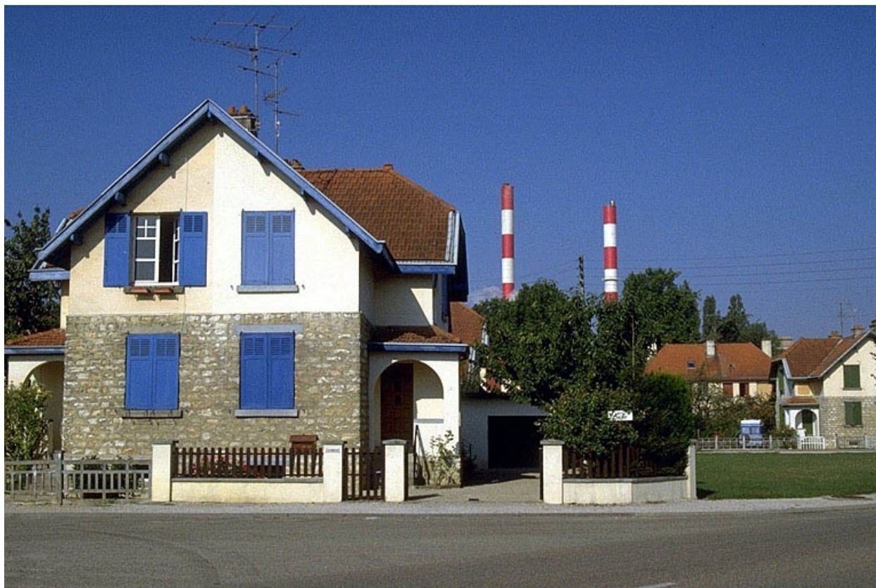
Façade antérieure vue de face.
