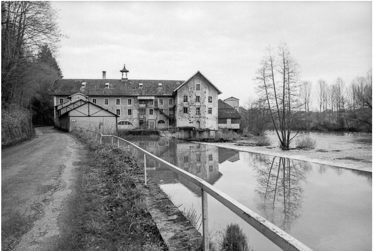
Vue d'ensemble depuis le sud en 1979.
