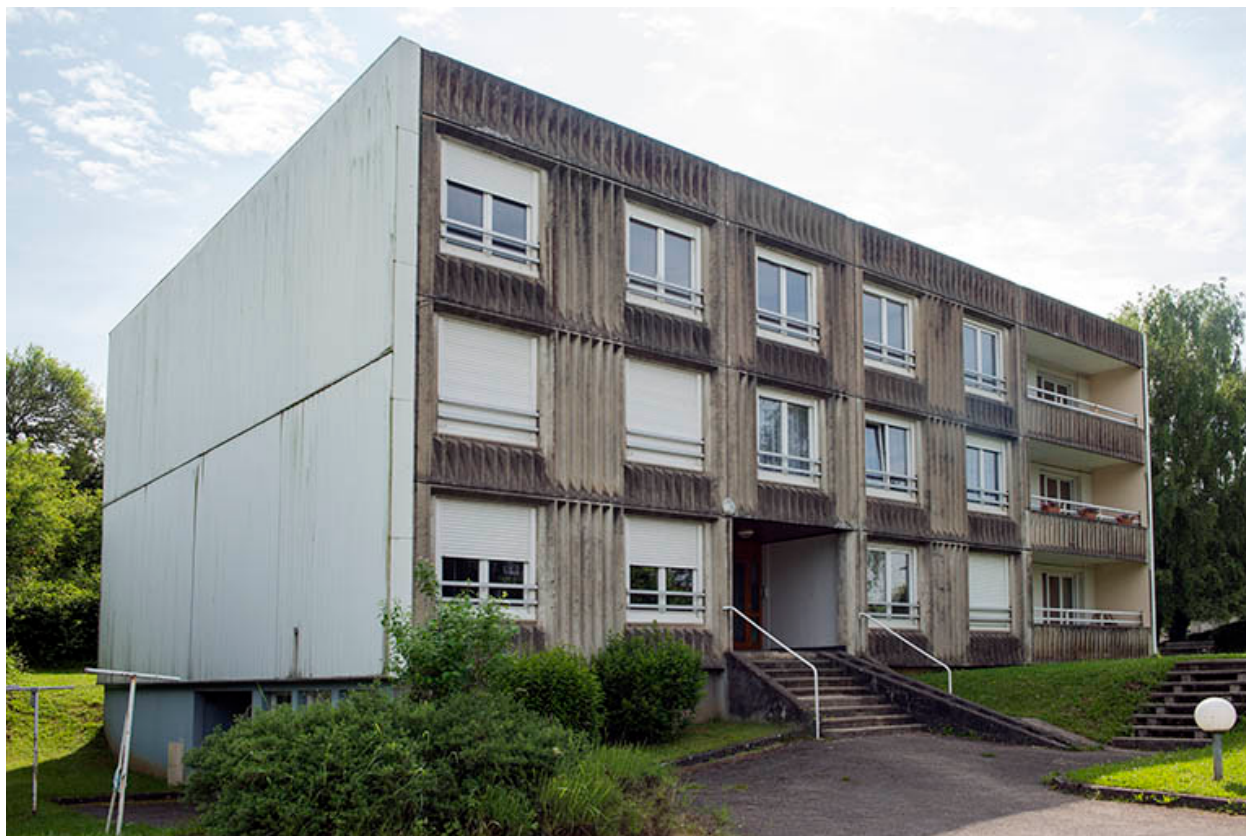
Angle ouest des logements de fonction.
