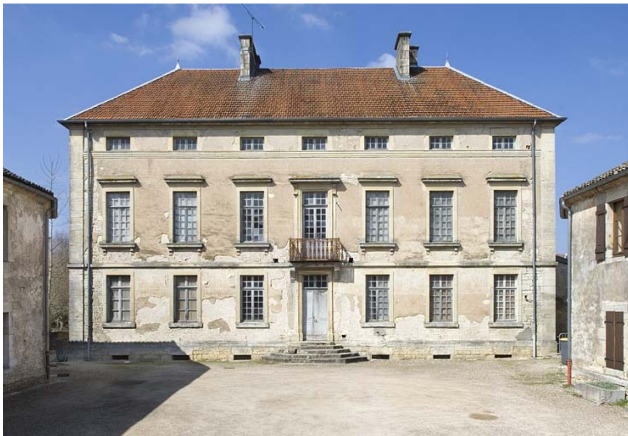
Logement patronal (31 rue Carnot). Façade antérieure.
