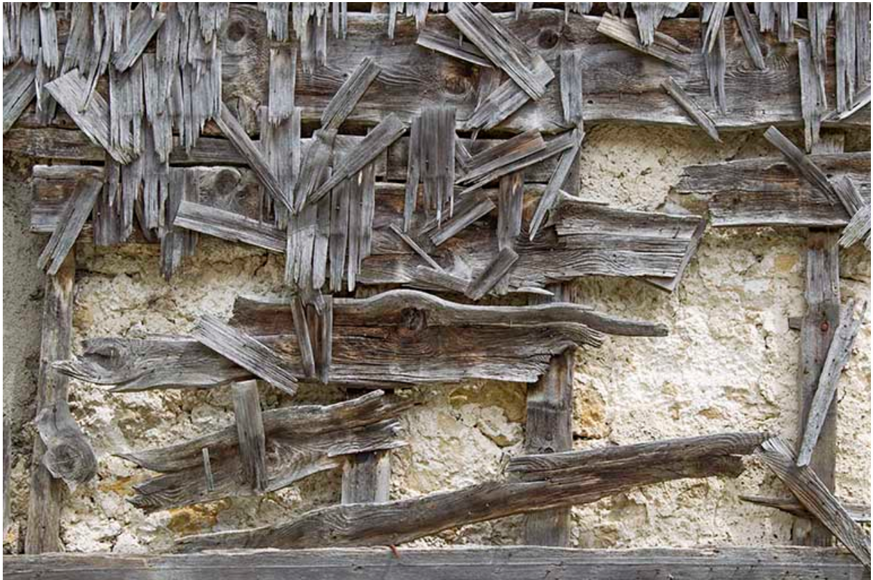
Façade postérieure : vestiges de l'essentage de tavaillons.
