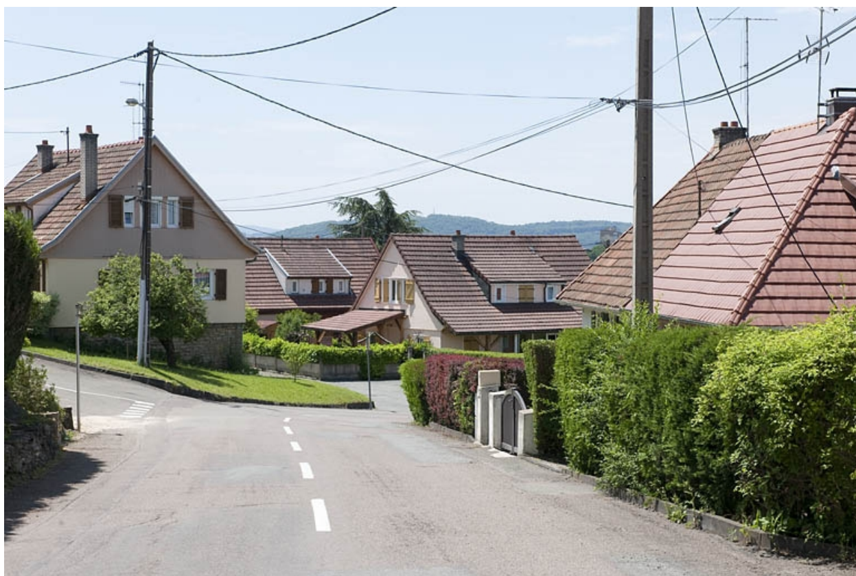
Maisons rue Kléber Gretz.
