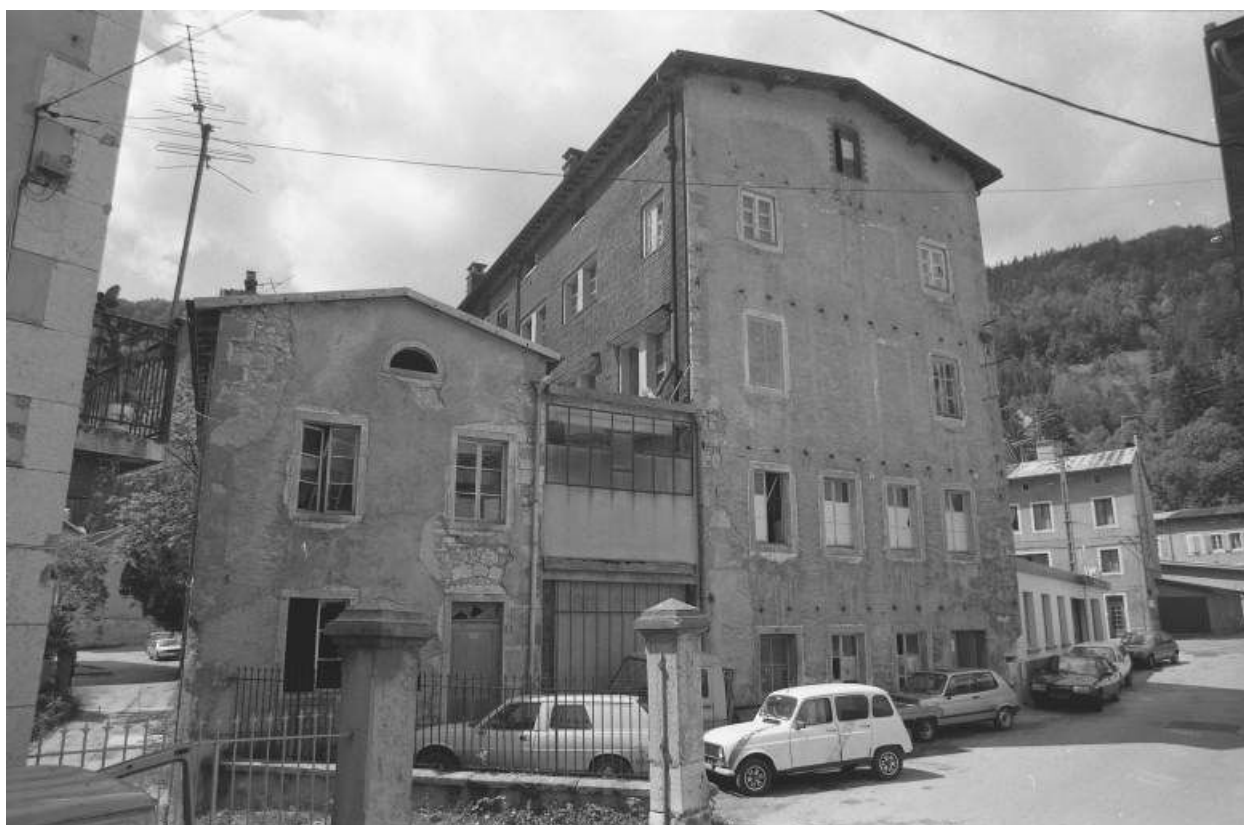
Bâtiment 6-8 rue Victor Poupin : façade latérale gauche.
