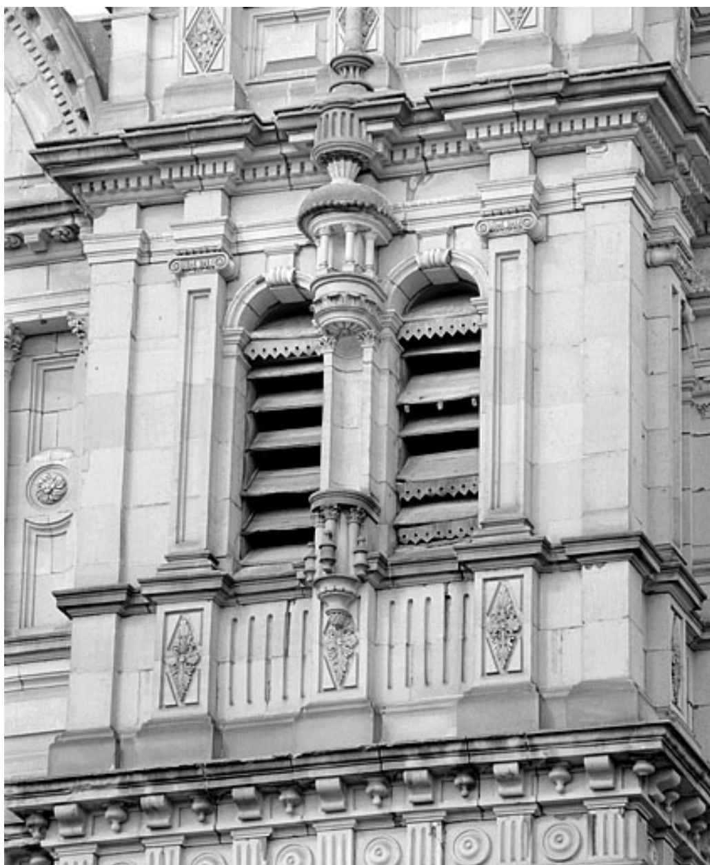
Deuxième niveau de la tour nord.
