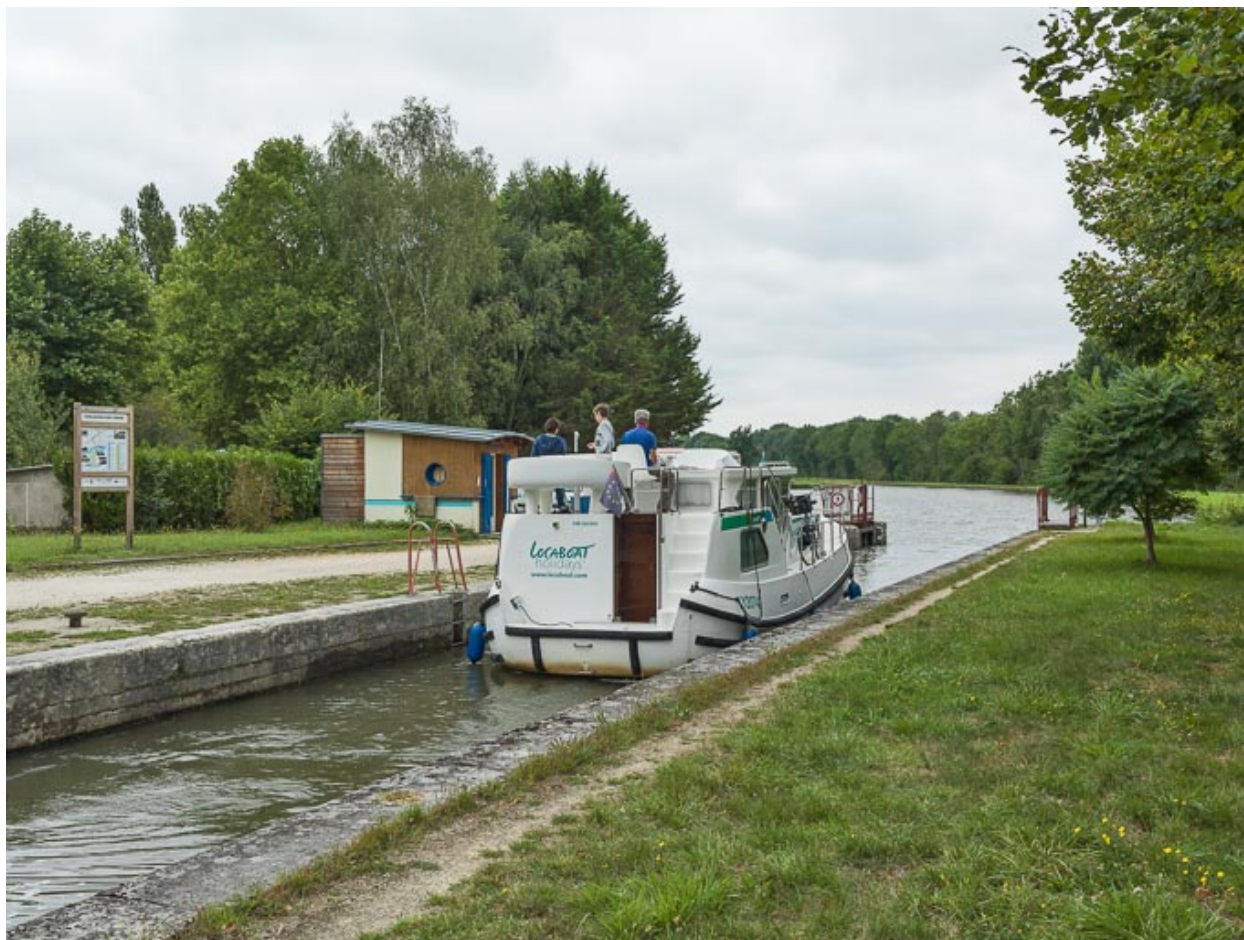
Vue du site d'écluse.
