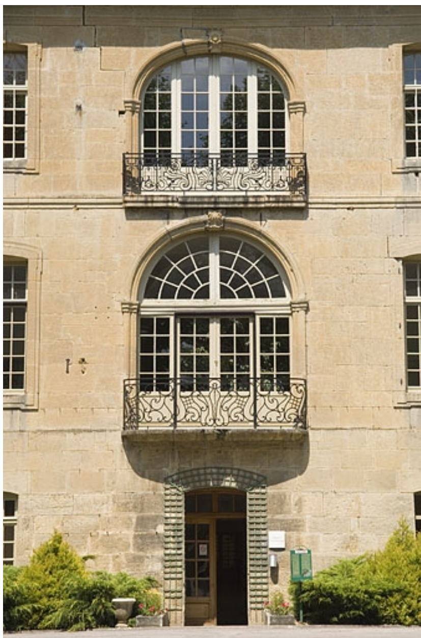
Façade sud du logis abbatial. Travée centrale.
