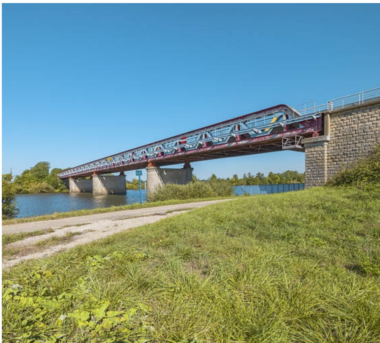
Vue d'ensemble du pont.
