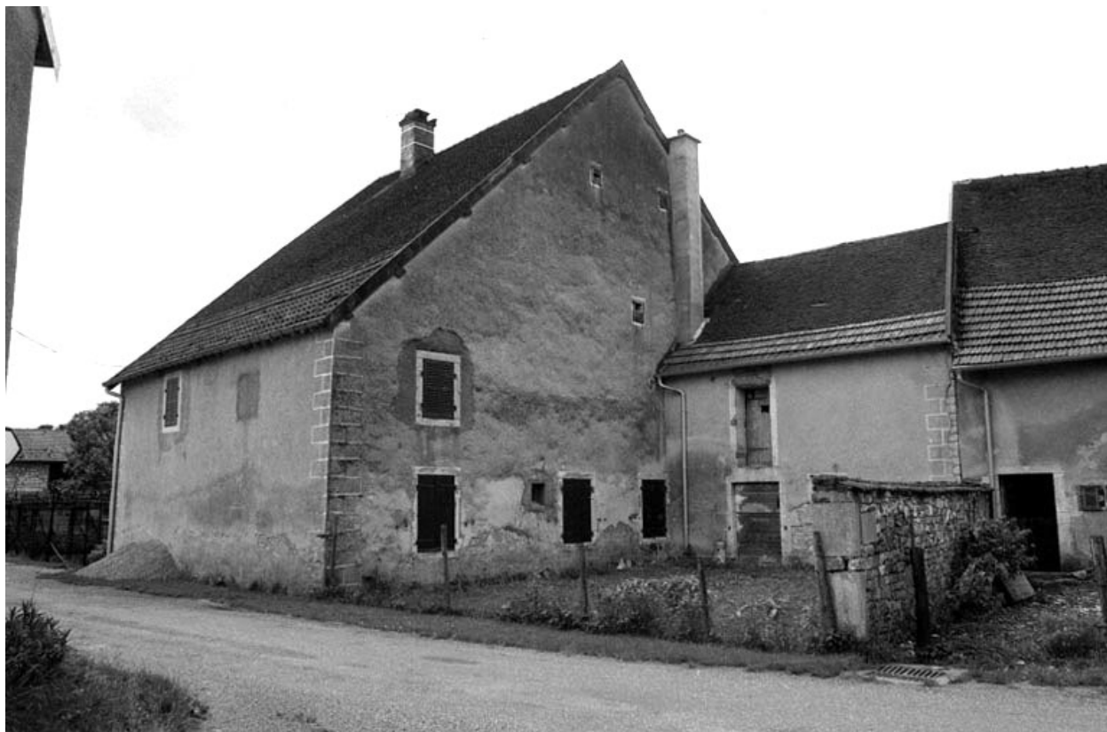
Façades postérieures et latérales droite.
