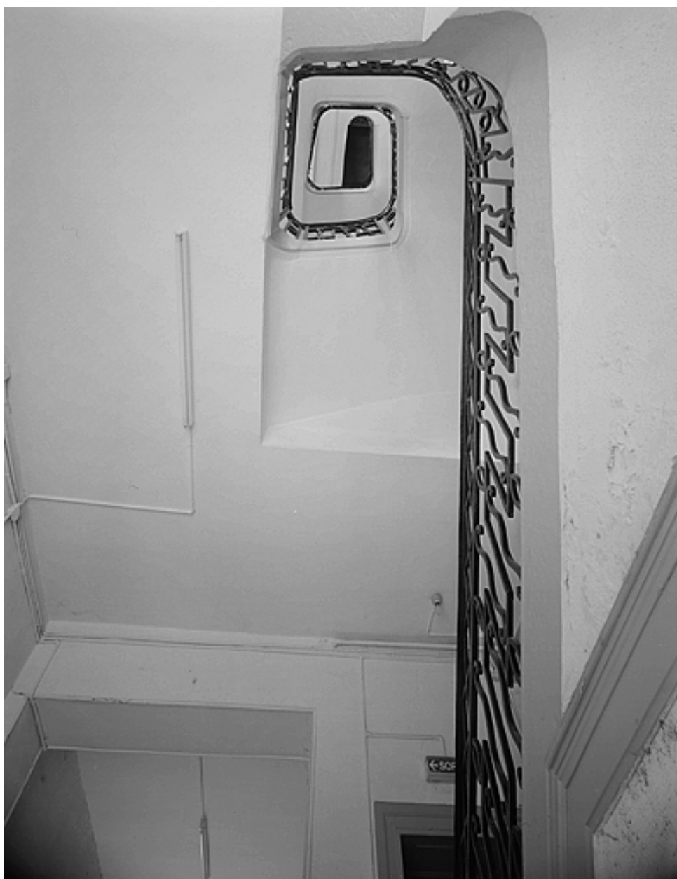
Vue d'ensemble de l'escalier.
