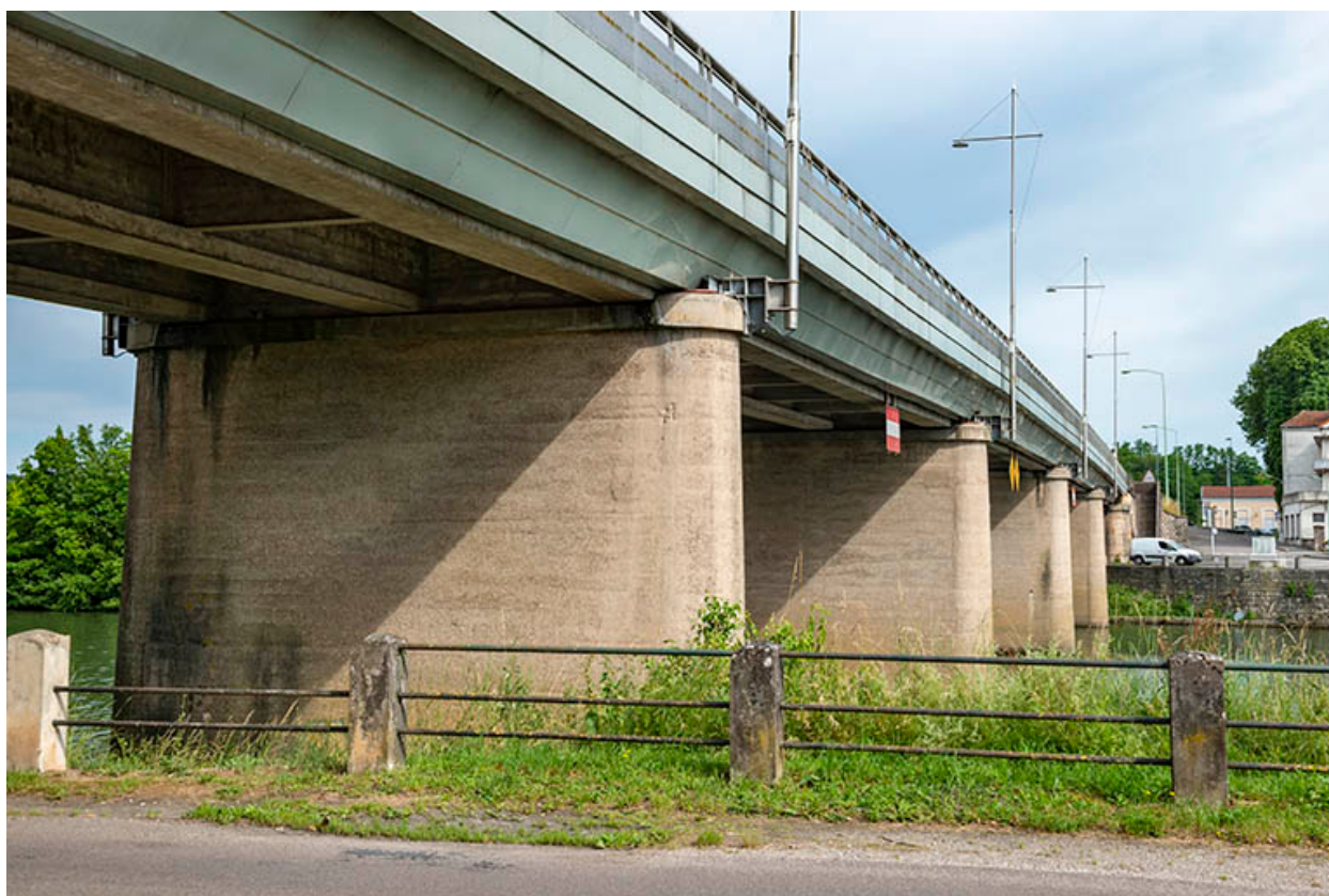
Vue de détail des piles du pont.
