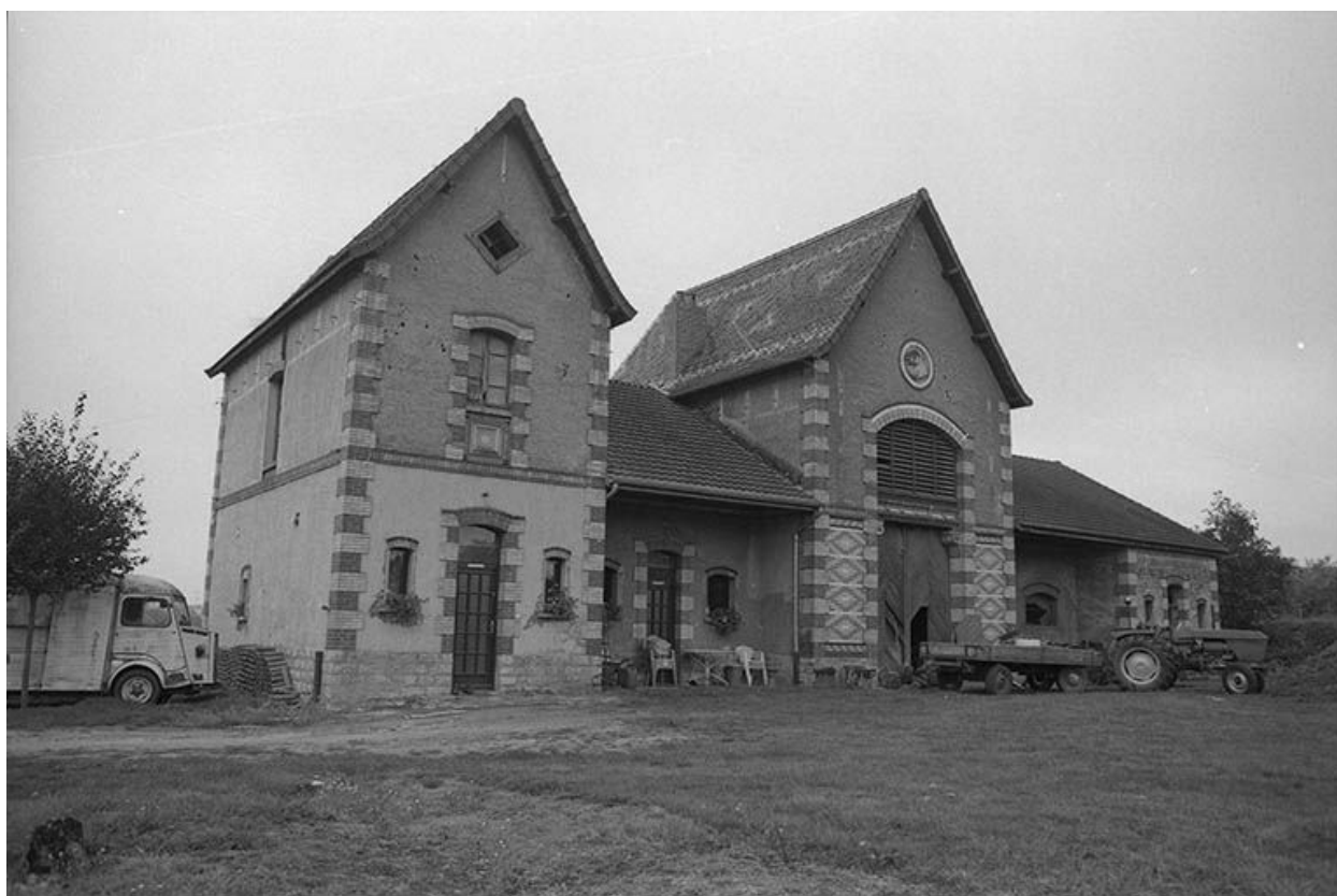
Façade est des écuries.
