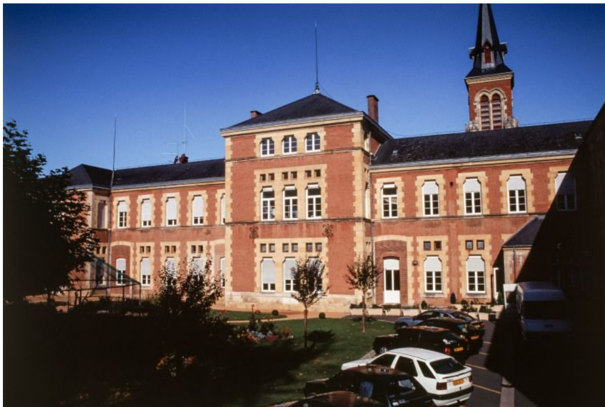
Façade postérieure de l'aile droite.
