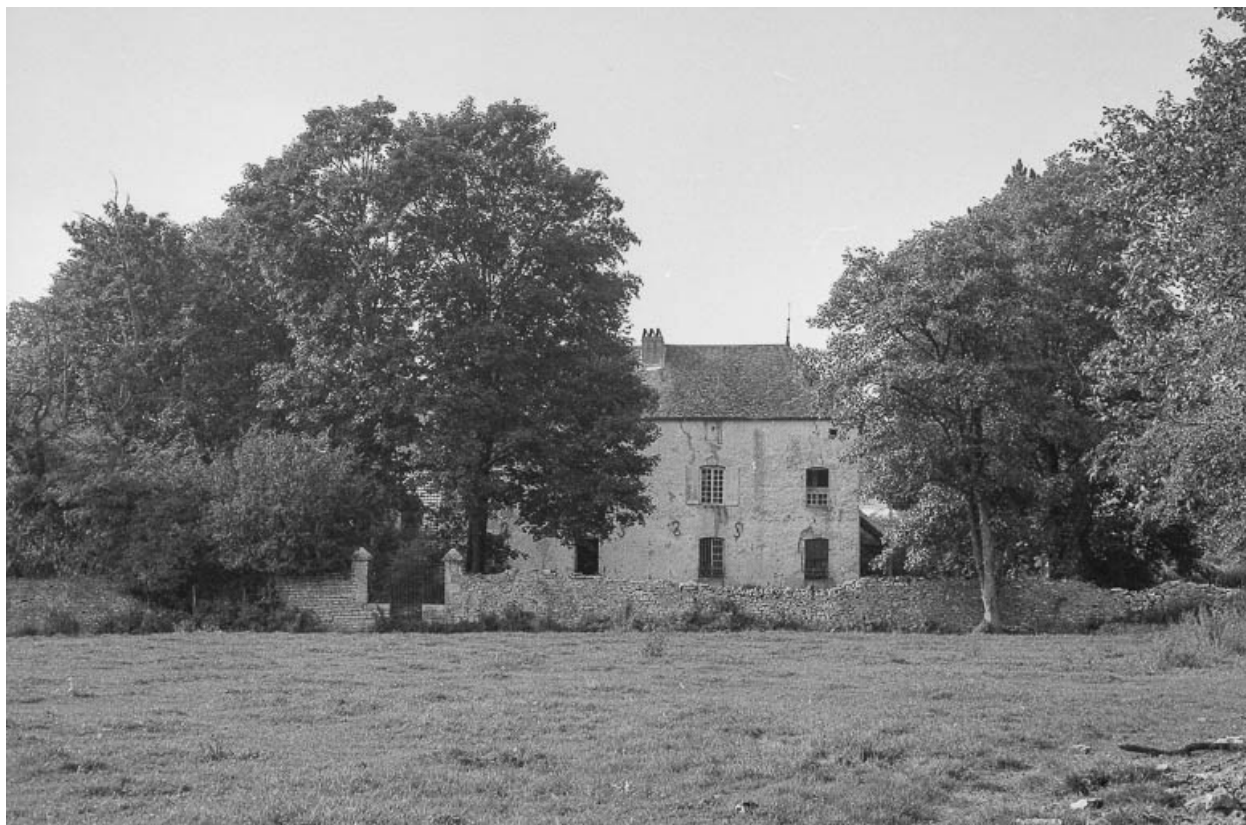
Façade sur le parc.
