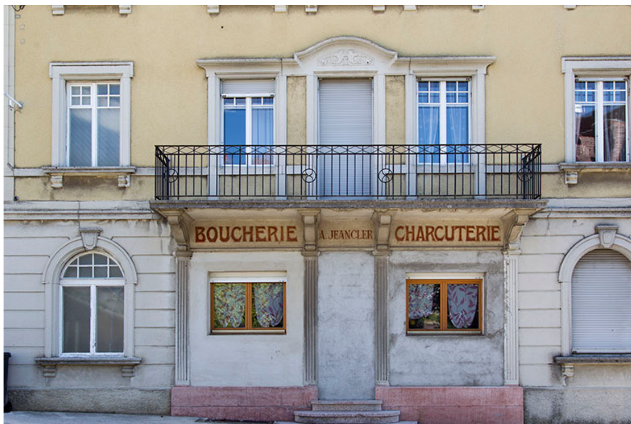
Façade antérieure : travées centrales.
