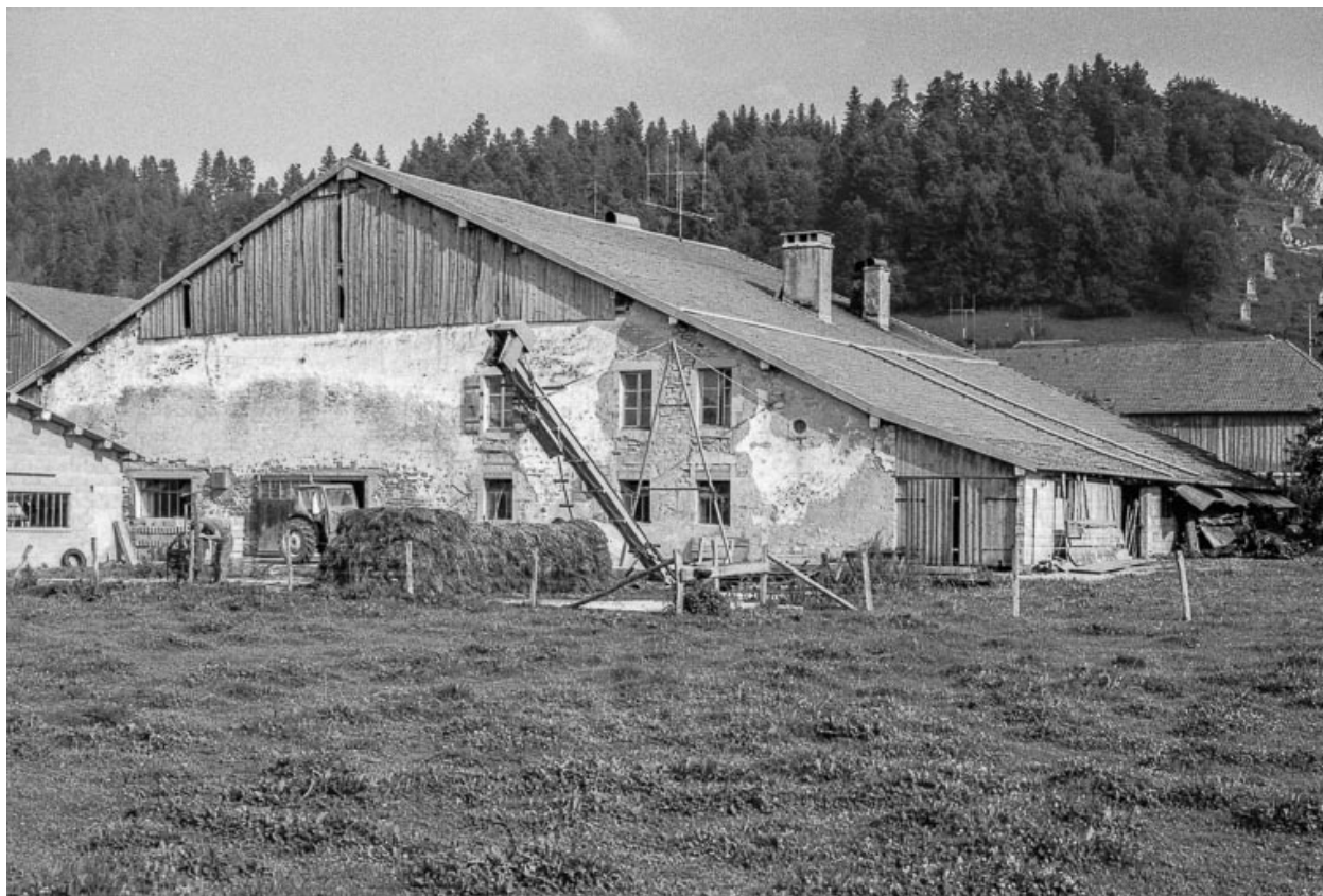
Ferme située 16 Grande Rue : façade postérieure.
