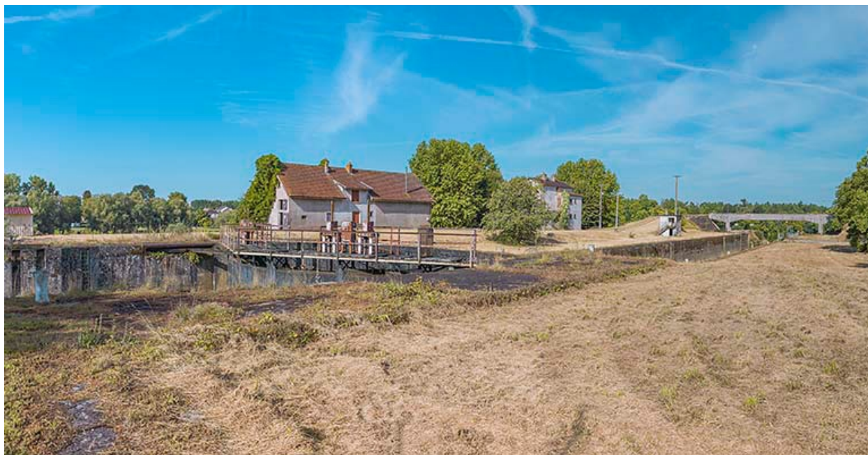
Vue d'ensemble du site d'écluse depuis l'amont.
