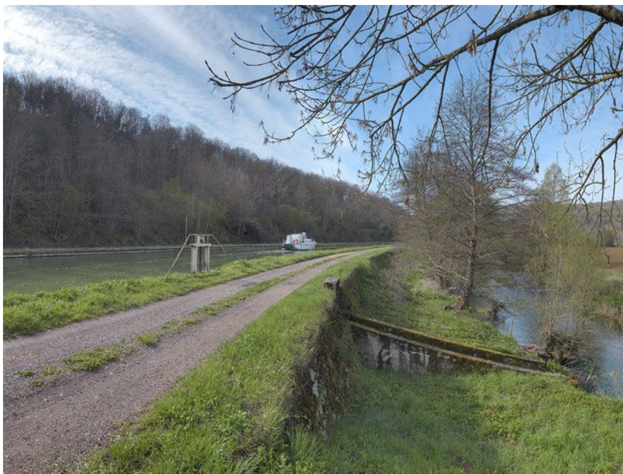
Le déversoir vu du chemin de halage.
