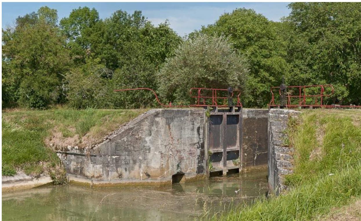
Vue du sas d'écluse en aval.
