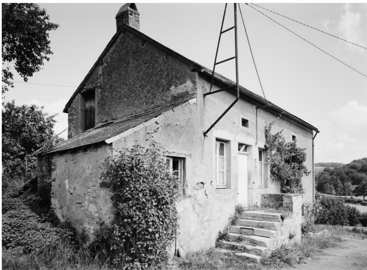
Détail de l'escalier du logis.
