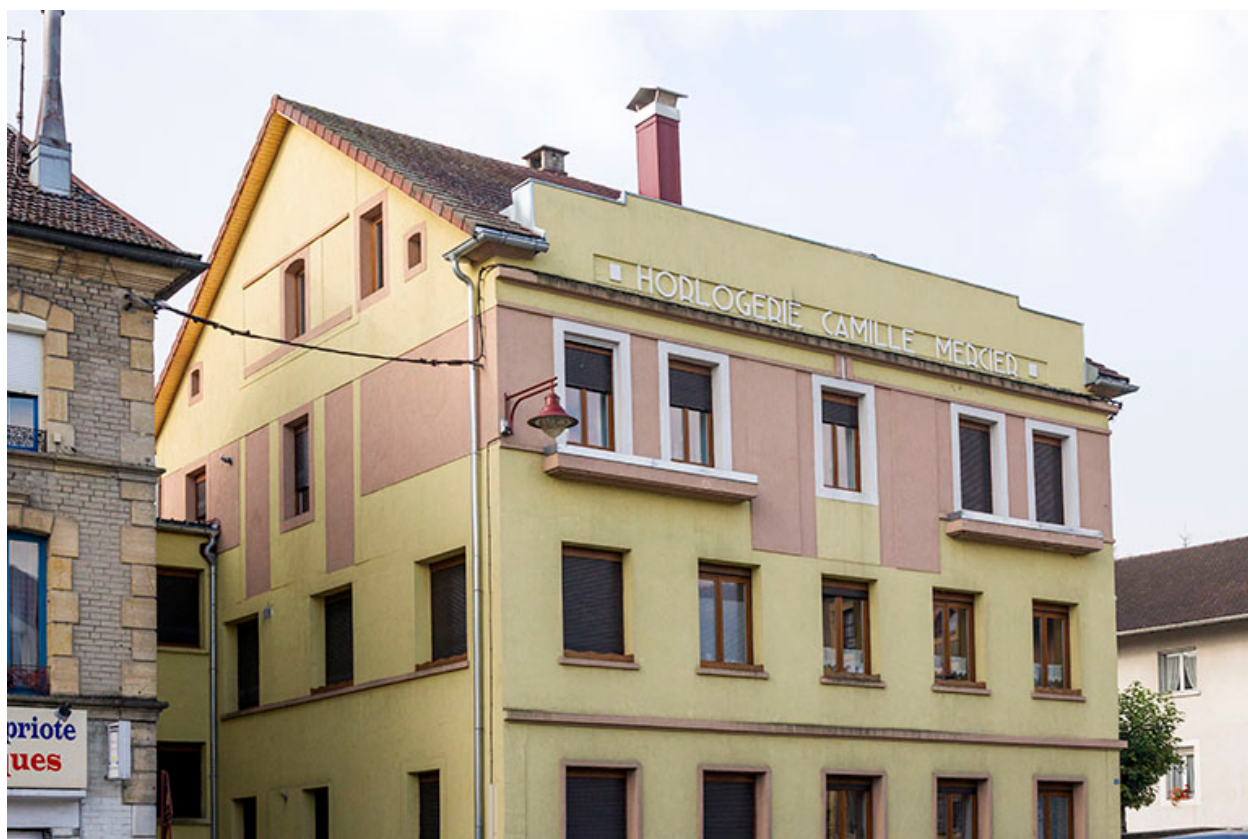
Immeuble : façades antérieure et latérale gauche.
