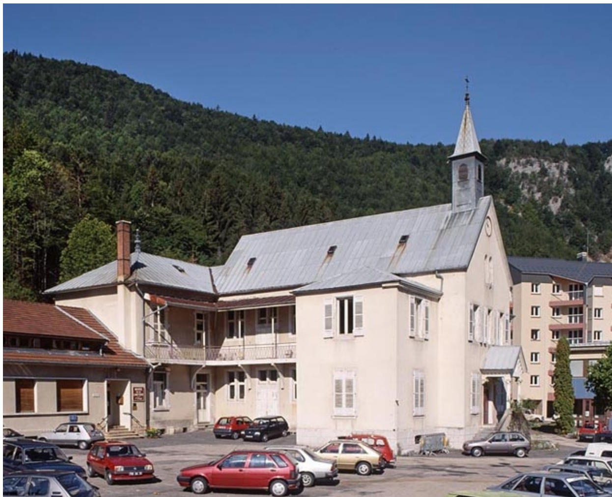
Façades antérieure et latérale gauche.
