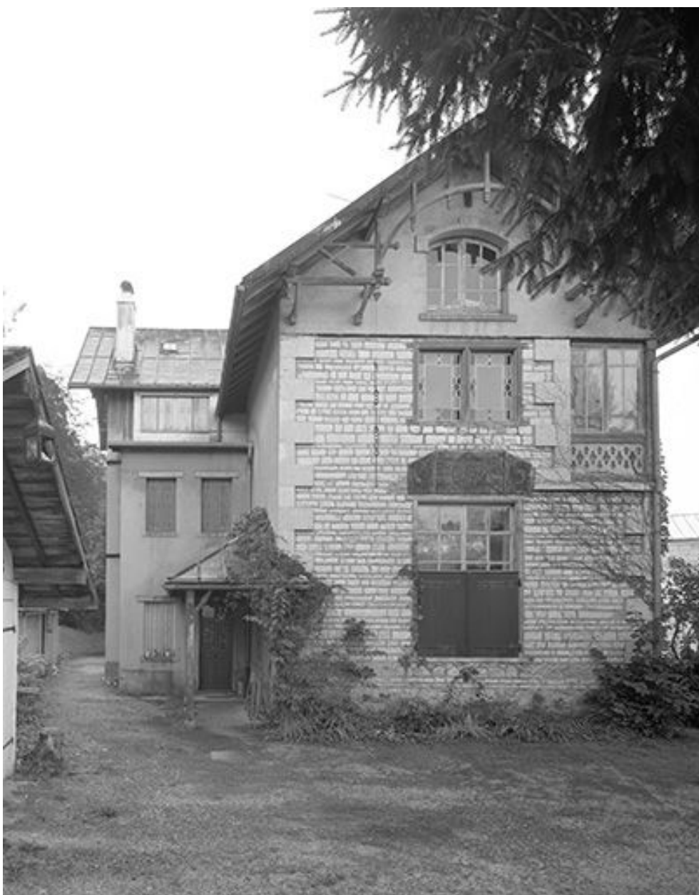
Vue rapprochée de la façade nord-ouest.
