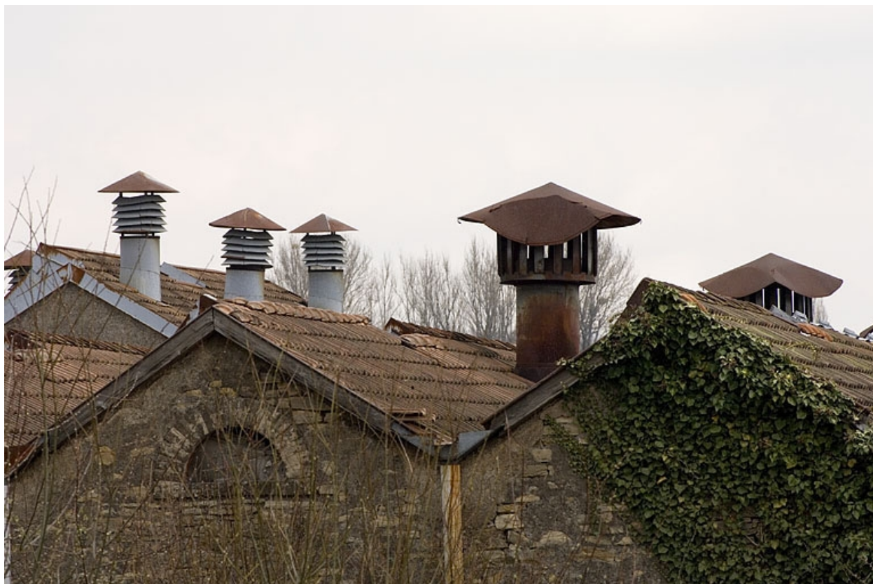
Cheminées métalliques de la salle de tissage.
