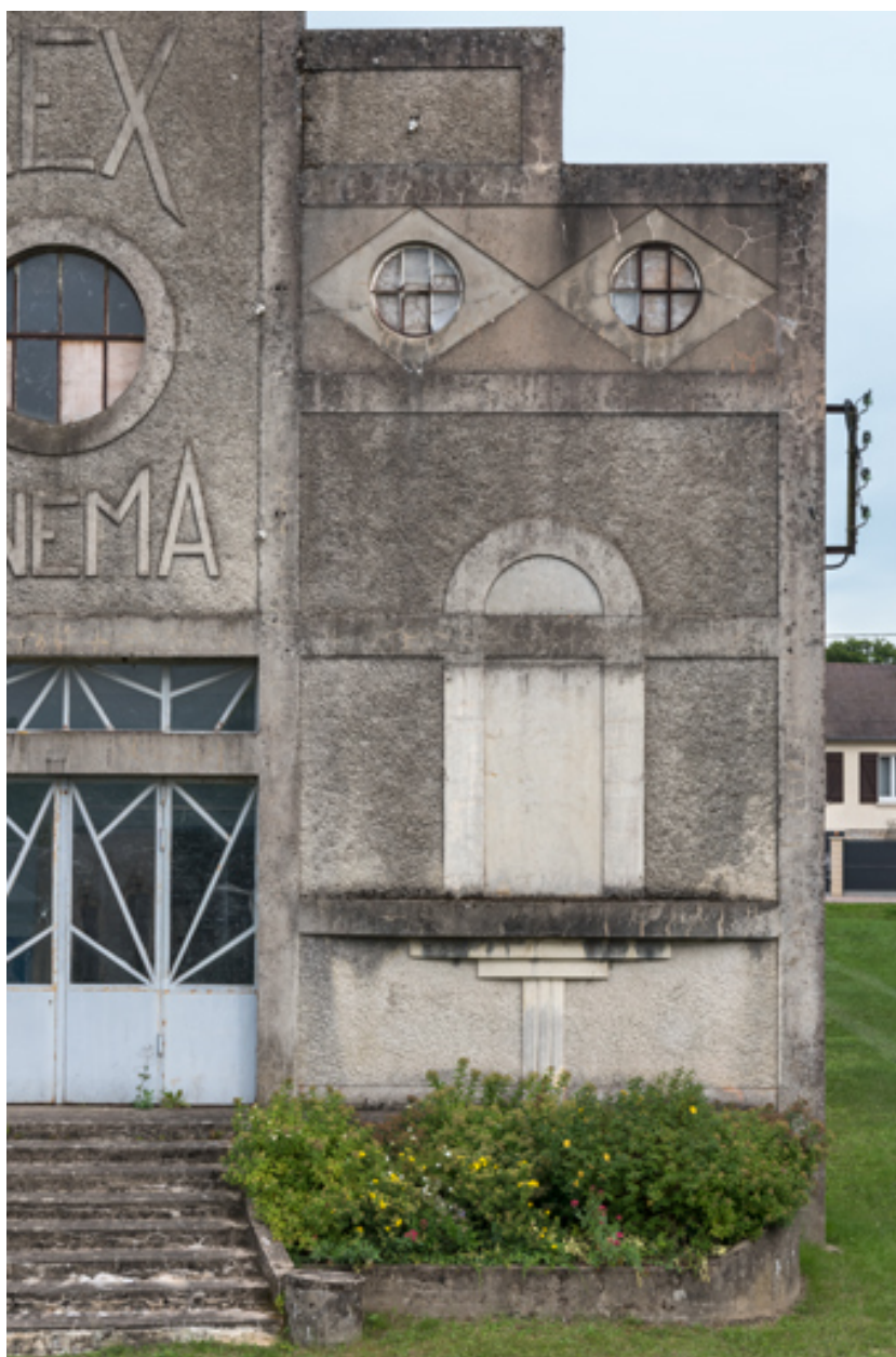
Façade antérieure : travée à droite.
