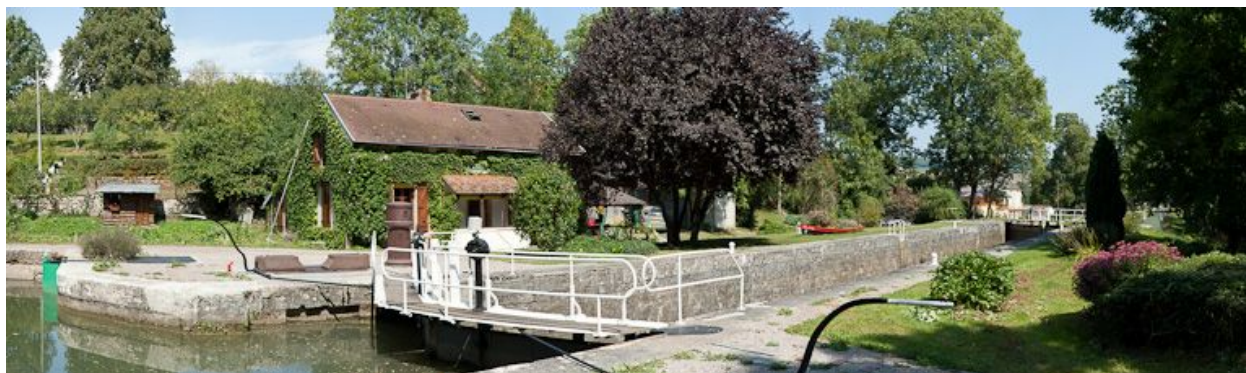
Vue du site d'écluse.
